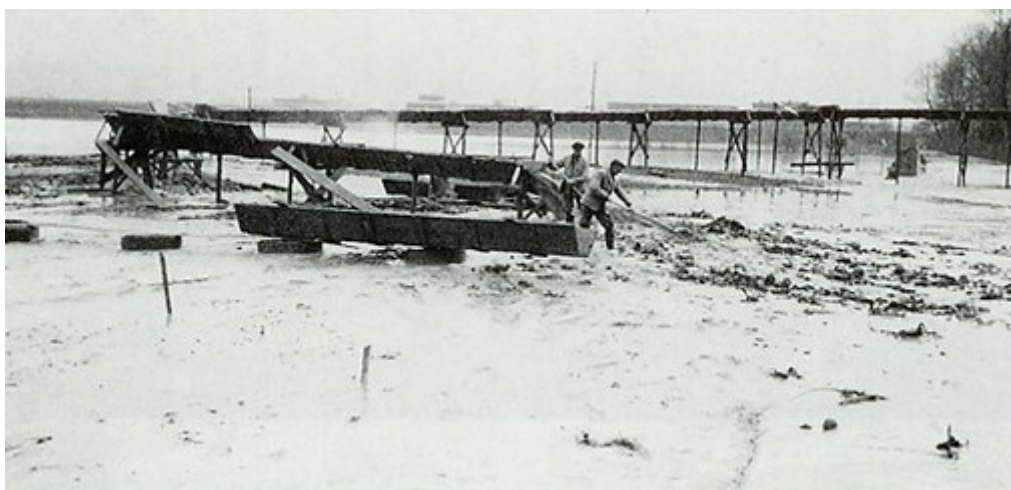
Obrázek 2 – Systém visutých dřevěných koryt
