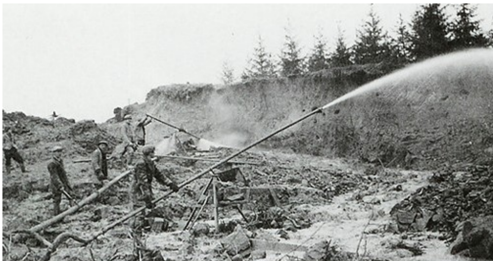
Obrázek 1 – Systém naplavování zeminy do prostoru k Bahňáku
