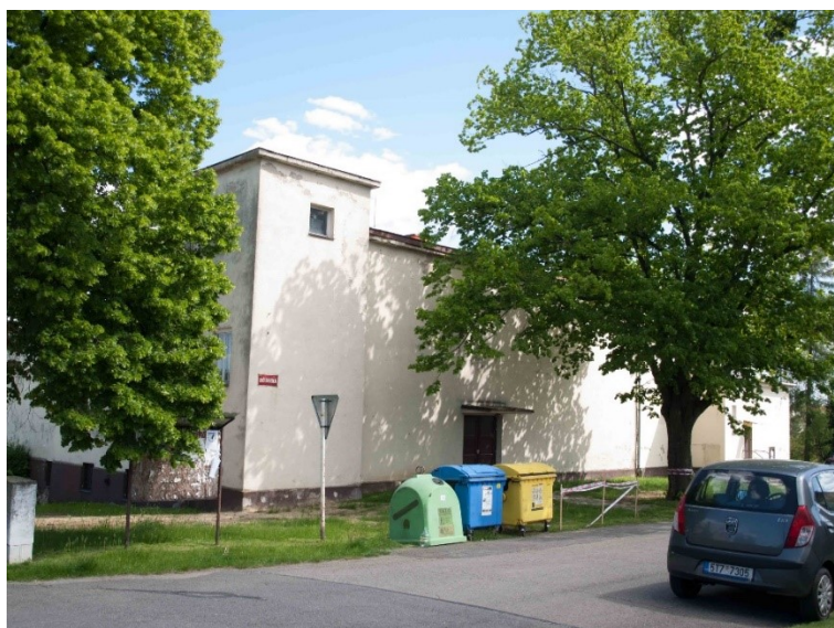
Obr. 23: Západní strana pohled 2
