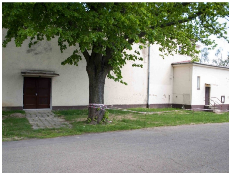
Obr. 24: Západní strana pohled 3
