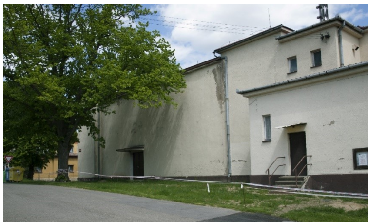
Obr. 22: Západní strana pohled 1
