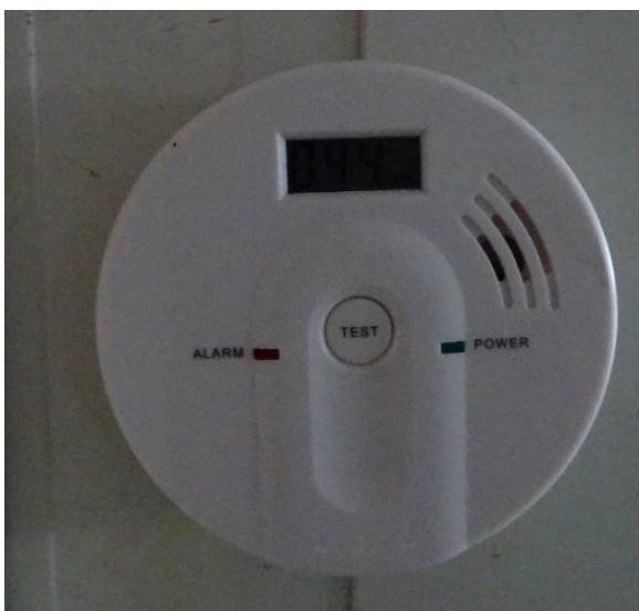
Obrázek 7 plynový detektor (zdroj vlastní)
