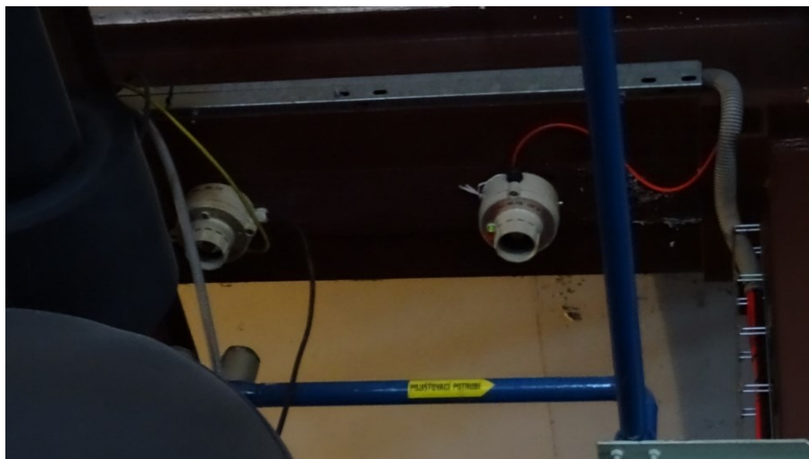
Obrázek 6 detektory nad chladicí soustavou (zdroj vlastní)
