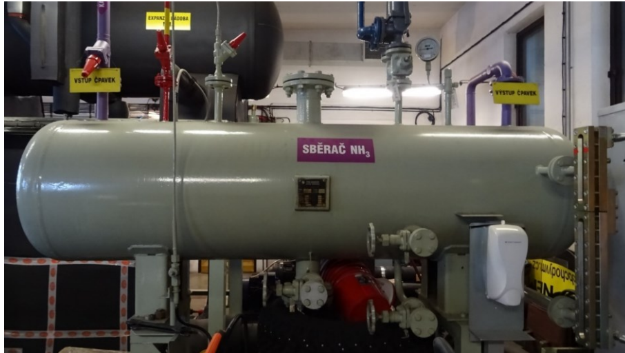
Obrázek 5 chladicí systém (zdroj vlastní)
