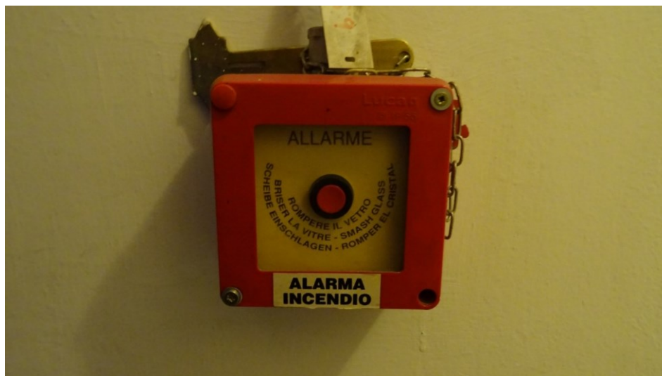
Obrázek 14 ruční hlásič (zdroj vlastní)
