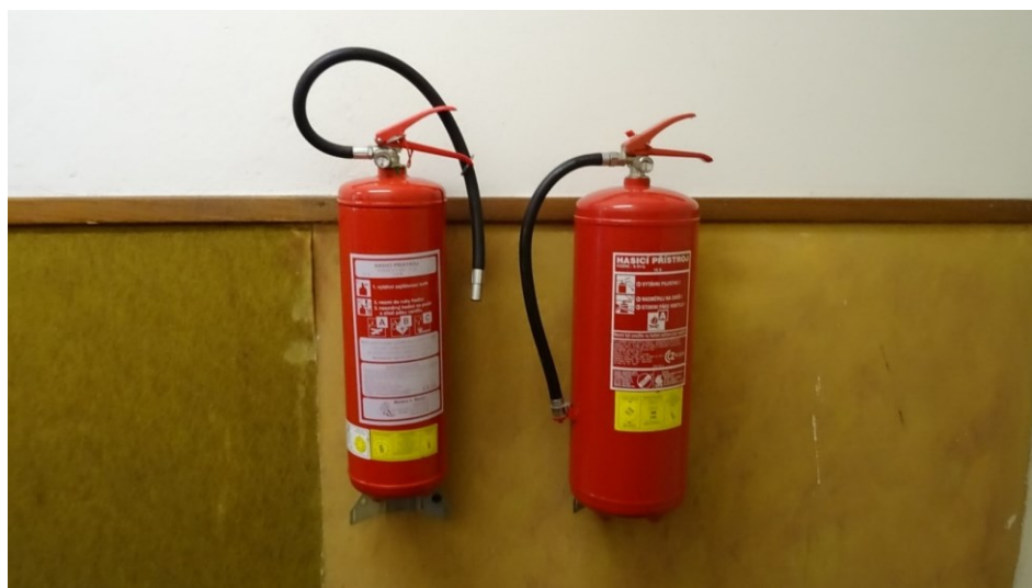
Obrázek 15 práškový a vodní hasicí přístroj (zdroj vlastní)
