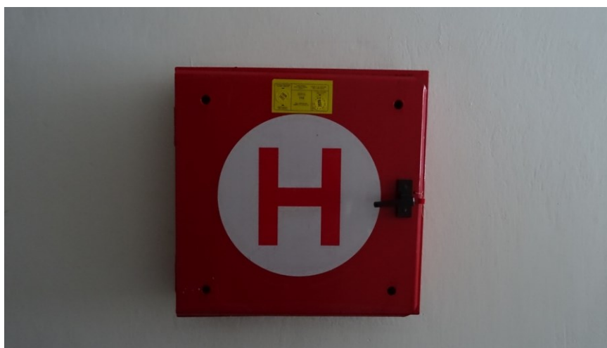
Obrázek 16 zapuštěný hydrant do zdi (zdroj vlastní)
