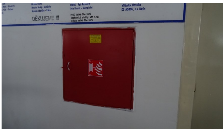
Obrázek 16 zapuštěný hydrant do zdi (zdroj vlastní)
