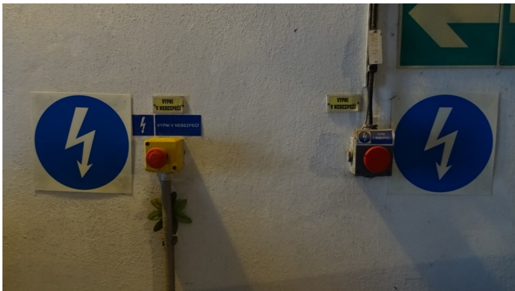
Obrázek 13 tlačítka nouzového vypnutí (zdroj vlastní)
