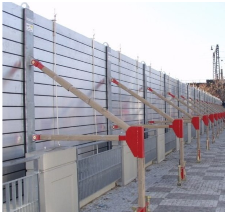
Obr. 7 Protipovodňová stěna
