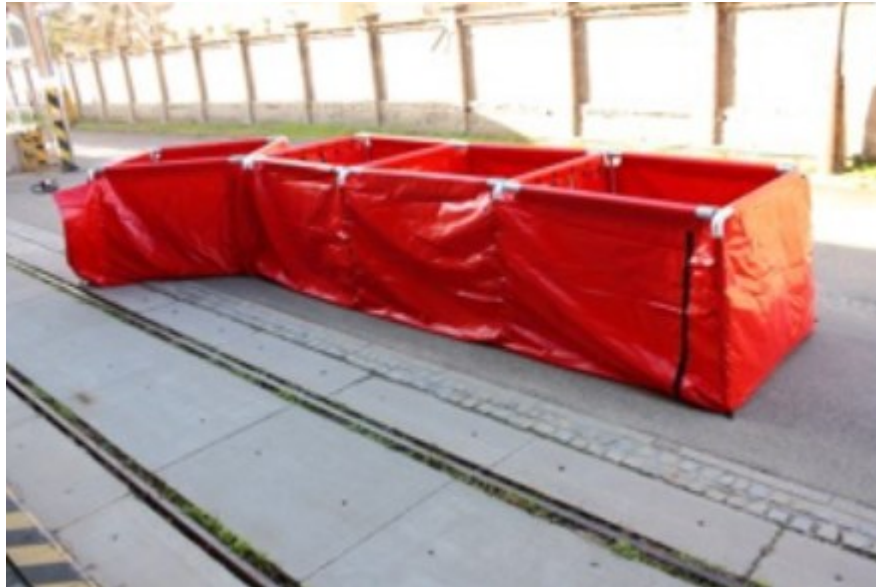
Obr. 5 Zábrana s ocelovou konstrukcí
