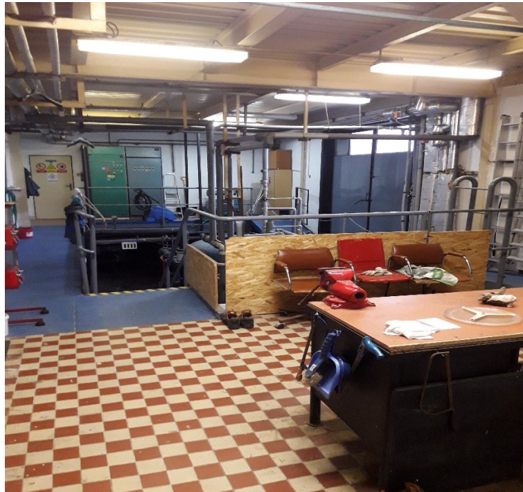
Obrázek 12 Prostor technického zázemí krytého bazénu.
