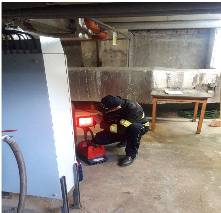
Obrázek 14 Instalace kouřového zařízení pro potřeby cvičení.
