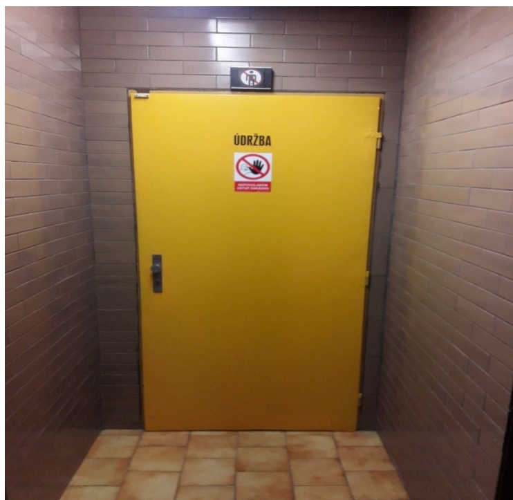
Obrázek 19 Stávající dveře vedoucí z technického prostoru krytého bazénu.
