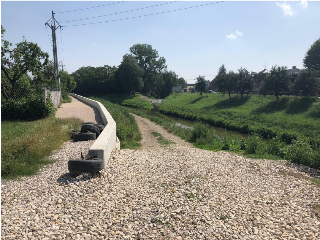
Obrázek 9 - Realizace protipovodňových opatření, zdroj: autor
