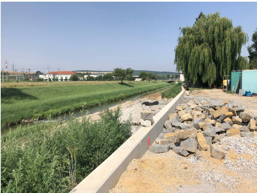
Obrázek 10 - Realizace protipovodňového opatření, zdroj: autor
