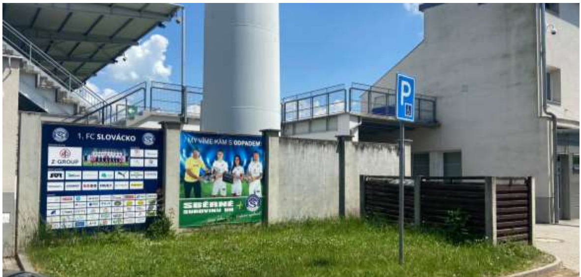
Obrázek č. 10: Betonové zdi kolem stadionu (Vlastní, 2021).
