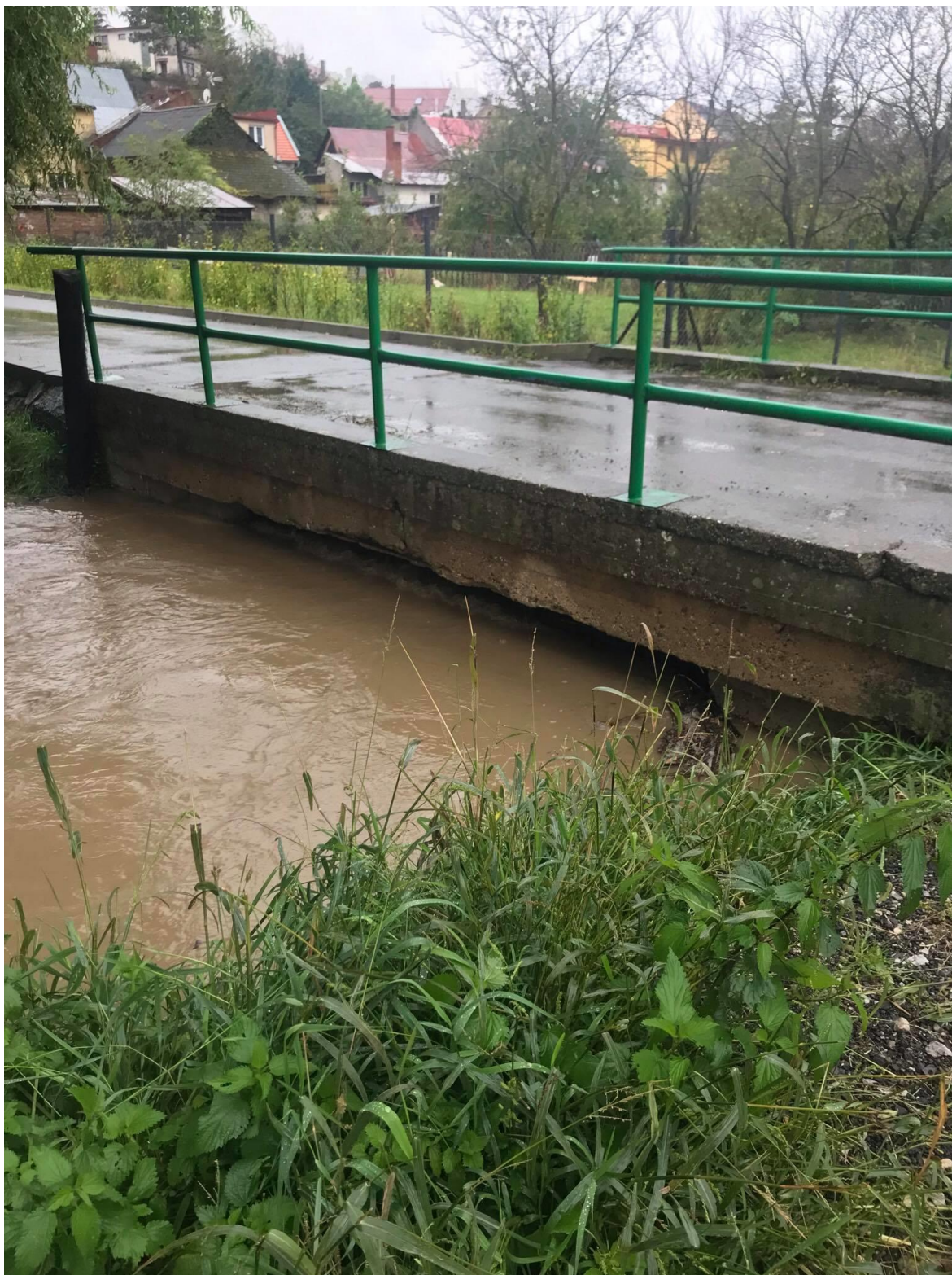
Obr. 33 – Most zasahující do koryta potoka, 2006 (vlastní)
