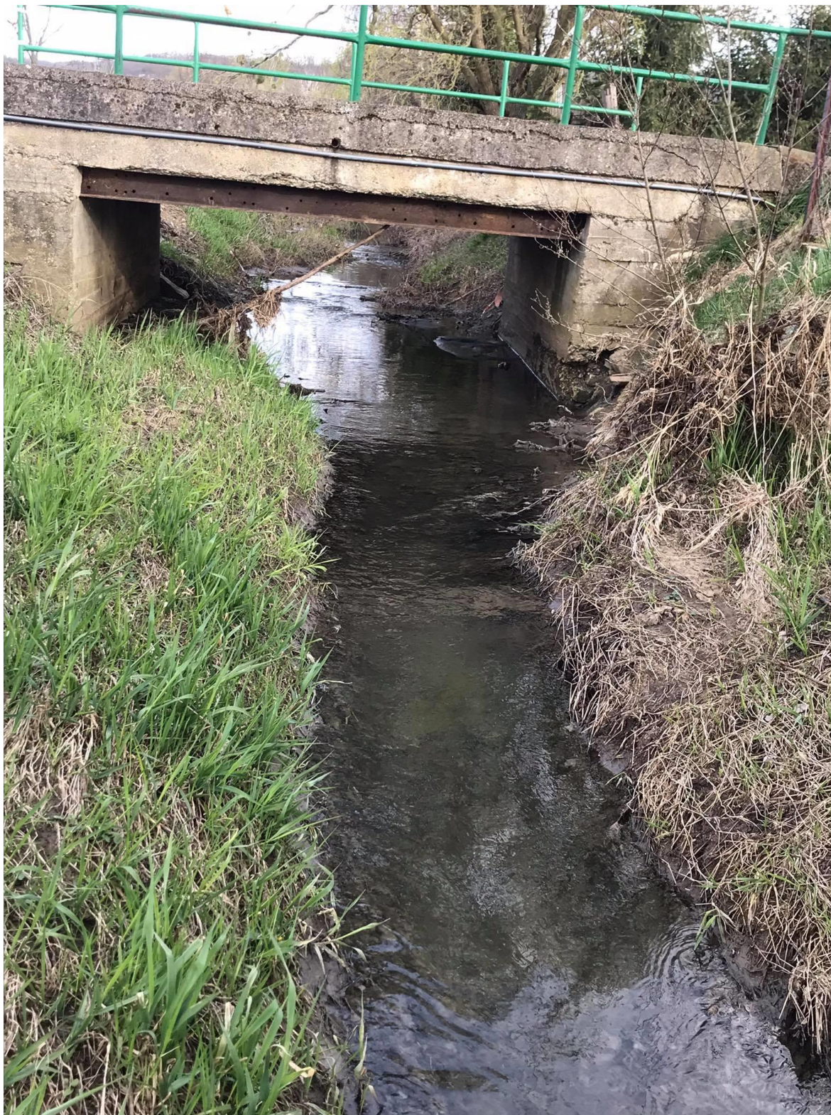
Obr. 16 – Most zasahující do koryta potoka (vlastní)
