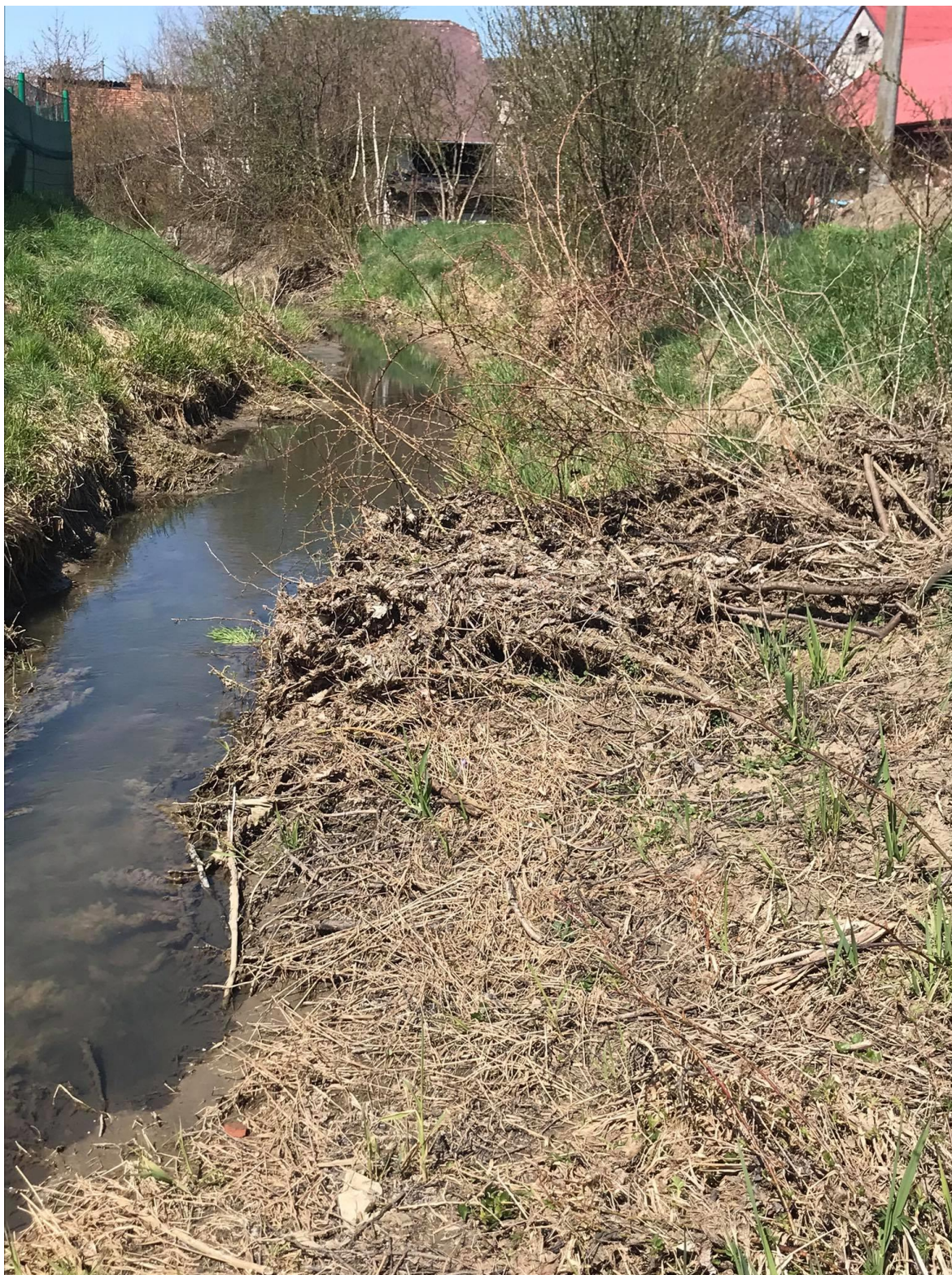
Obr. 19 – Zanesení koryta v ulici U Potoka (vlastní)
