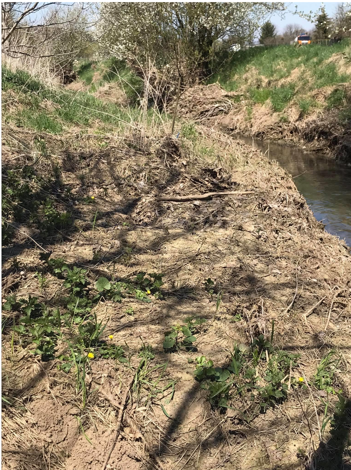
Obr. 27 – Zúžení koryta o 4 metry za zahradami ulice Přerovská (vlastní)
