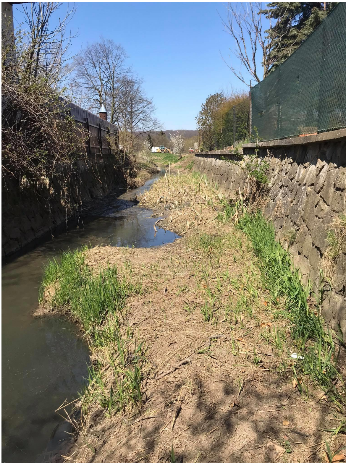
Obr. 23 – Zúžení betonového koryta (vlastní)
