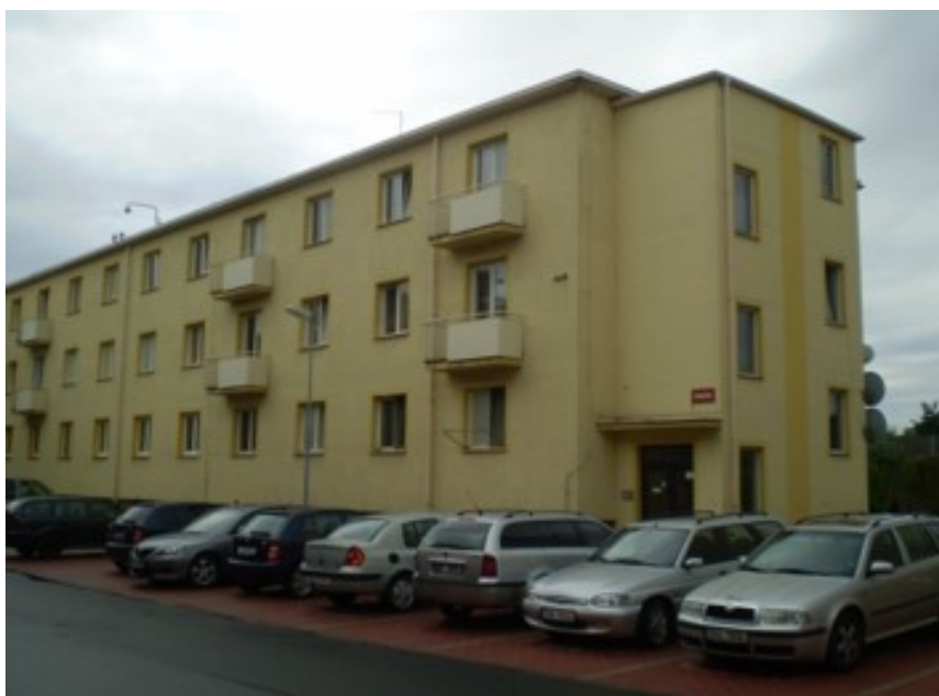
Obrázek č. 15 – Městská ubytovna (Ubytovna Lovosice, 2018)
