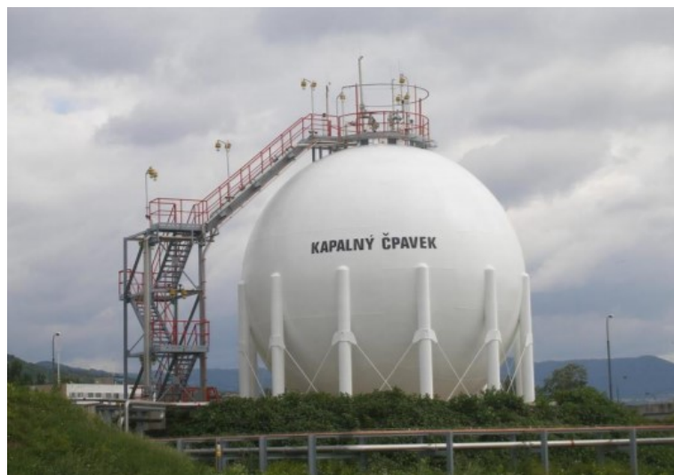
Obrázek č. 9 – Kulový zásobník čpavku (Smrž, b. r.)
