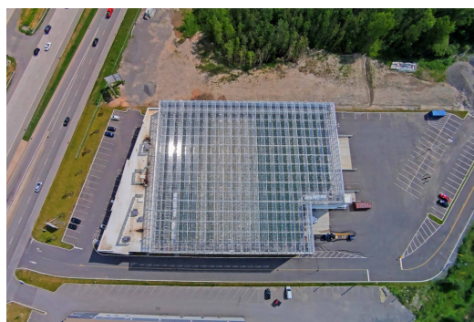
Obr. 8 / Střešní skleník Lufa Farms, Kanada
