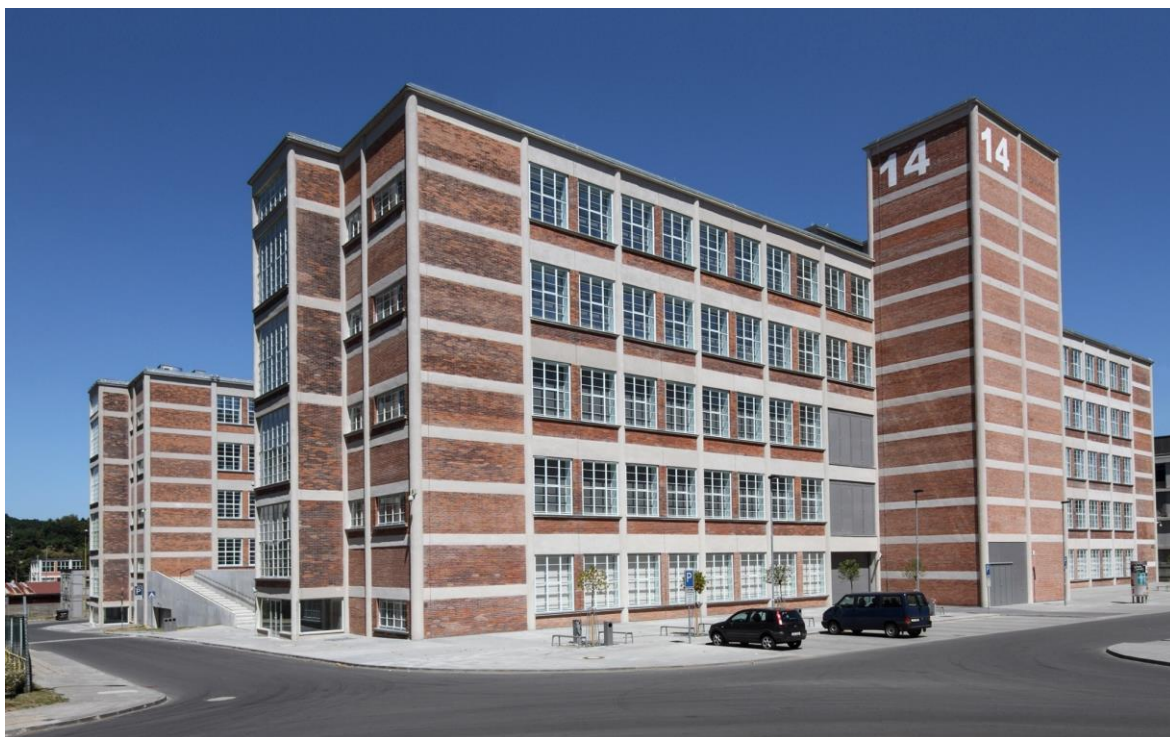
Obrázek 37: 14|15 BAŤŮV INSTITUT budova 14, (zdroj: Dalibor Novotný)
