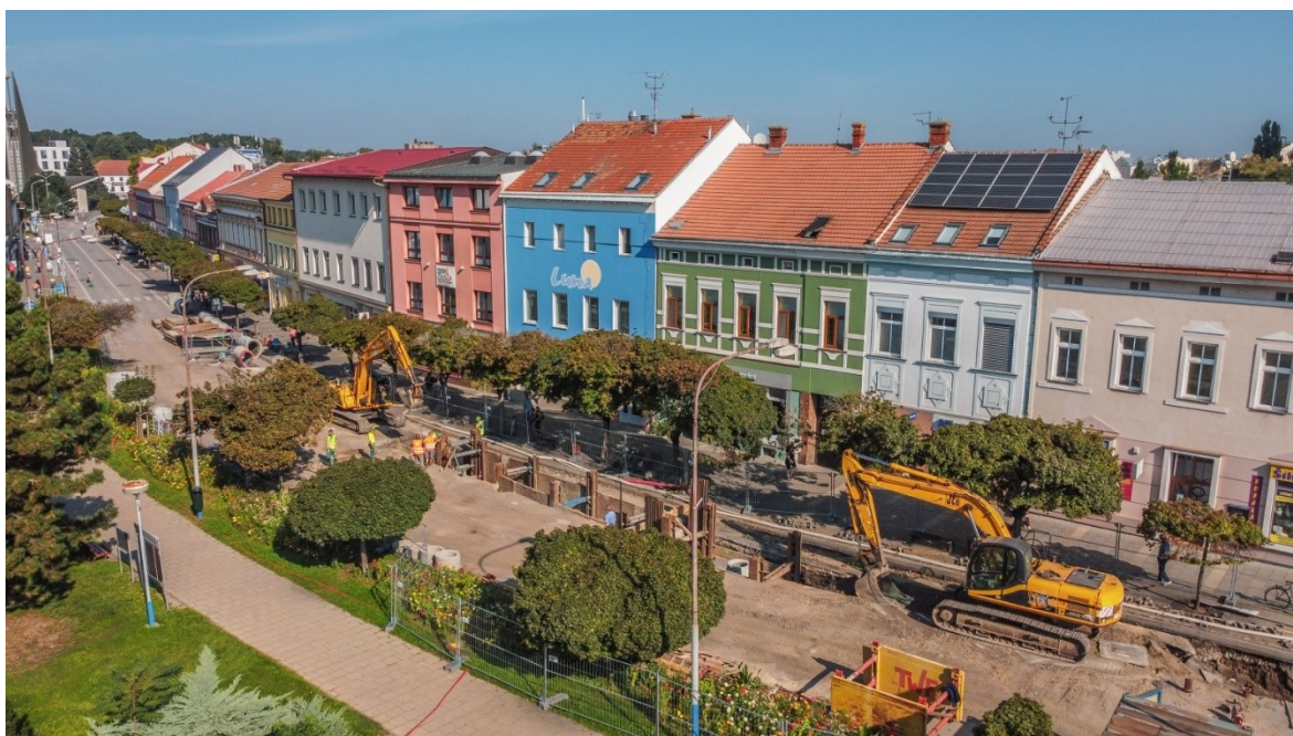
Obrázek 3 – Práce společnosti VHS Břeclav s.r.o.
