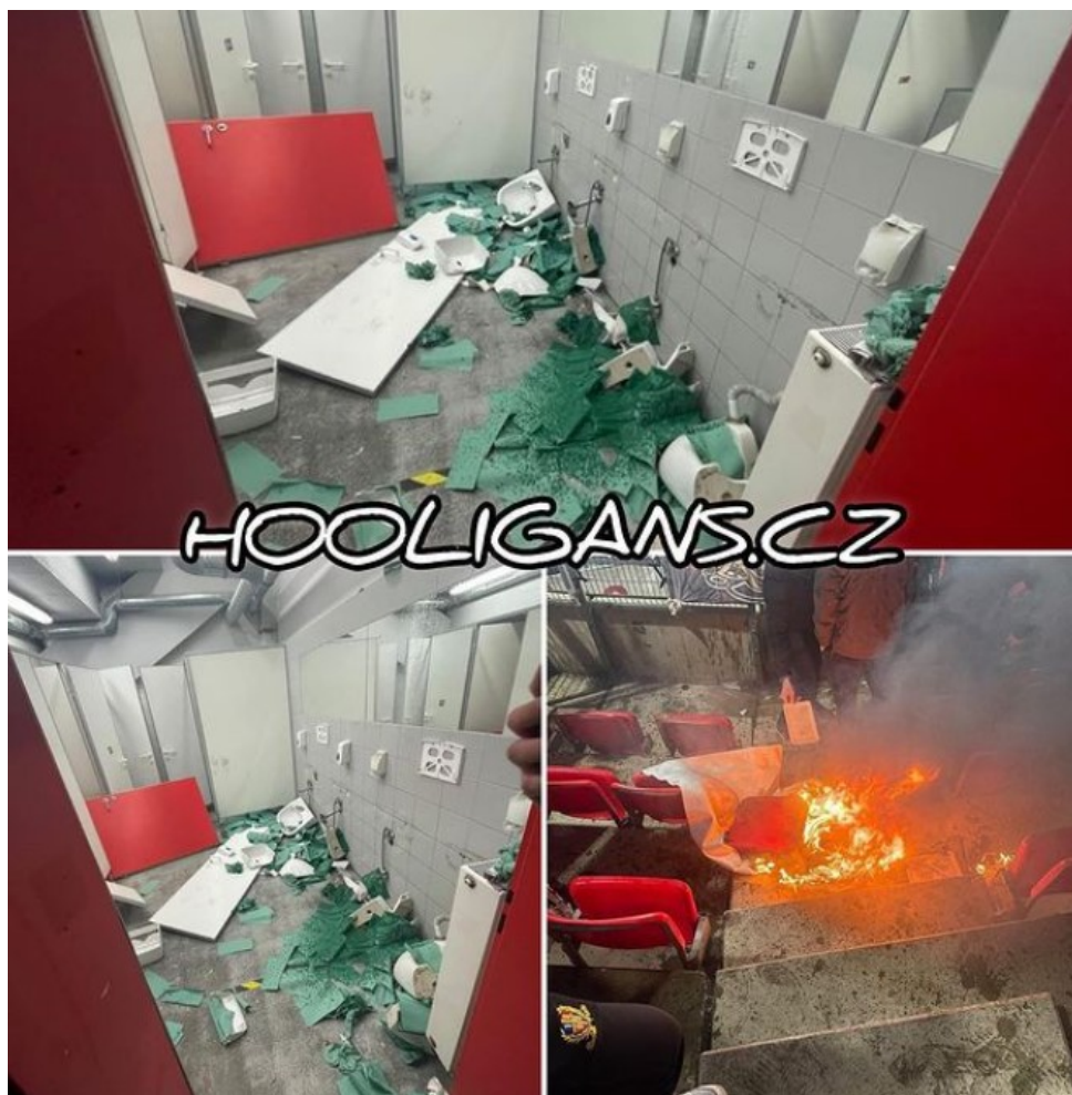
Obrázek 42 – Poškozené WC na Slávii se Spartou (Zdroj: hooligans.cz)
