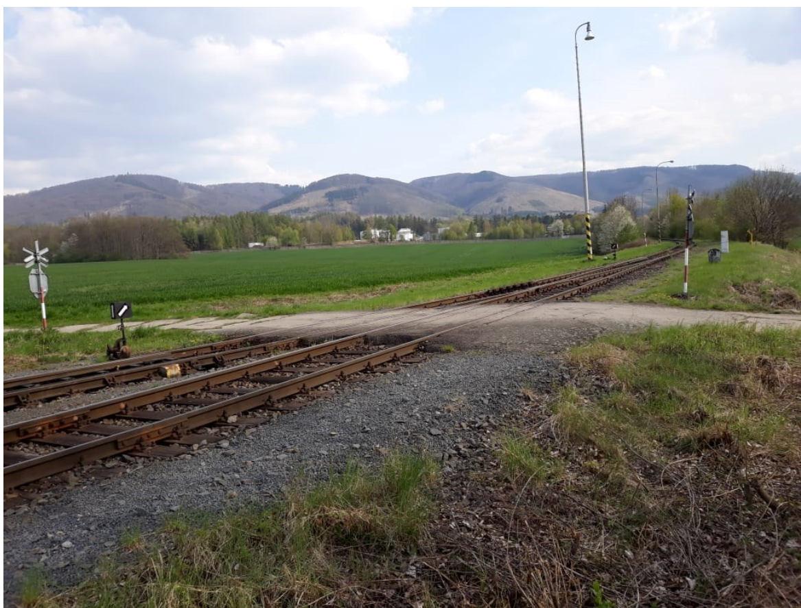
Obrázek 15: Místo možného vzniku havárie, kde se kříží železniční vlečka a polní komunikace (vlastní zdroj, 2022)
