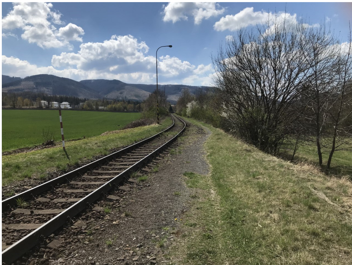
Obrázek 6: Lokalita modelového úniku ropné látky na železniční vlečce (vlastní zdroj)
