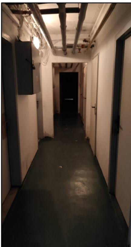
Společná chodba sklepních místností, první dveře na pravé straně vedou do místnosti využité k tvorbě návrhu improvizovaného úkrytu, druhé dveře na pravé straně vedou k rozvodům vody a kanalizace nacházejících se v té samé místnosti, zdroj: (Vlastní).
