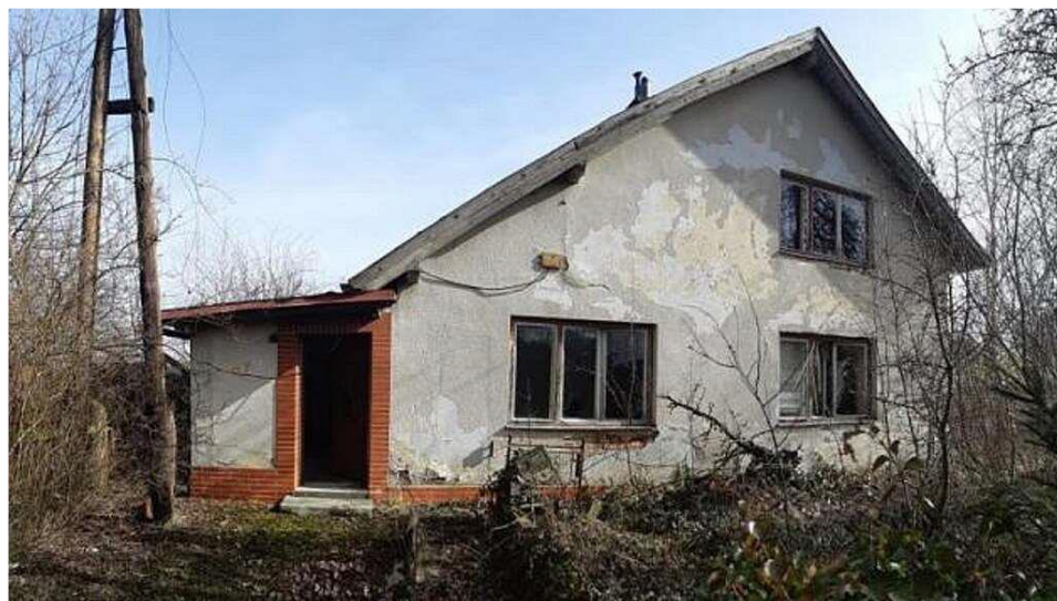
Obrázek 44: Budova drážního domku (Město Slavičín, © 2000-2022)
