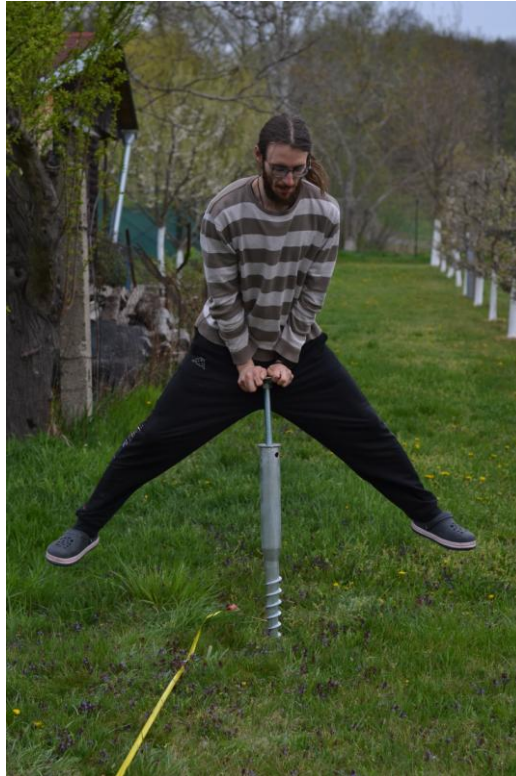
Obrázek 22 – Kotvení zemního vrutu
