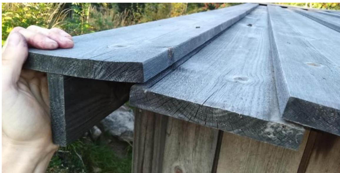
Obrázek 12 – Detail drážky řešení prken přístřešku od Snøhetty
