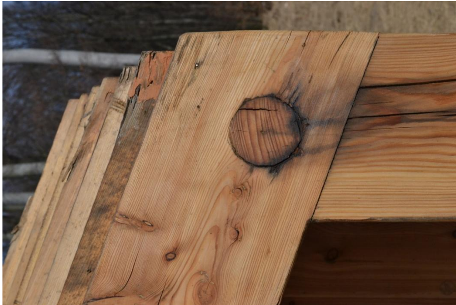
Obrázek 4 – Detail zakončení závitové tyče na rozhledně
