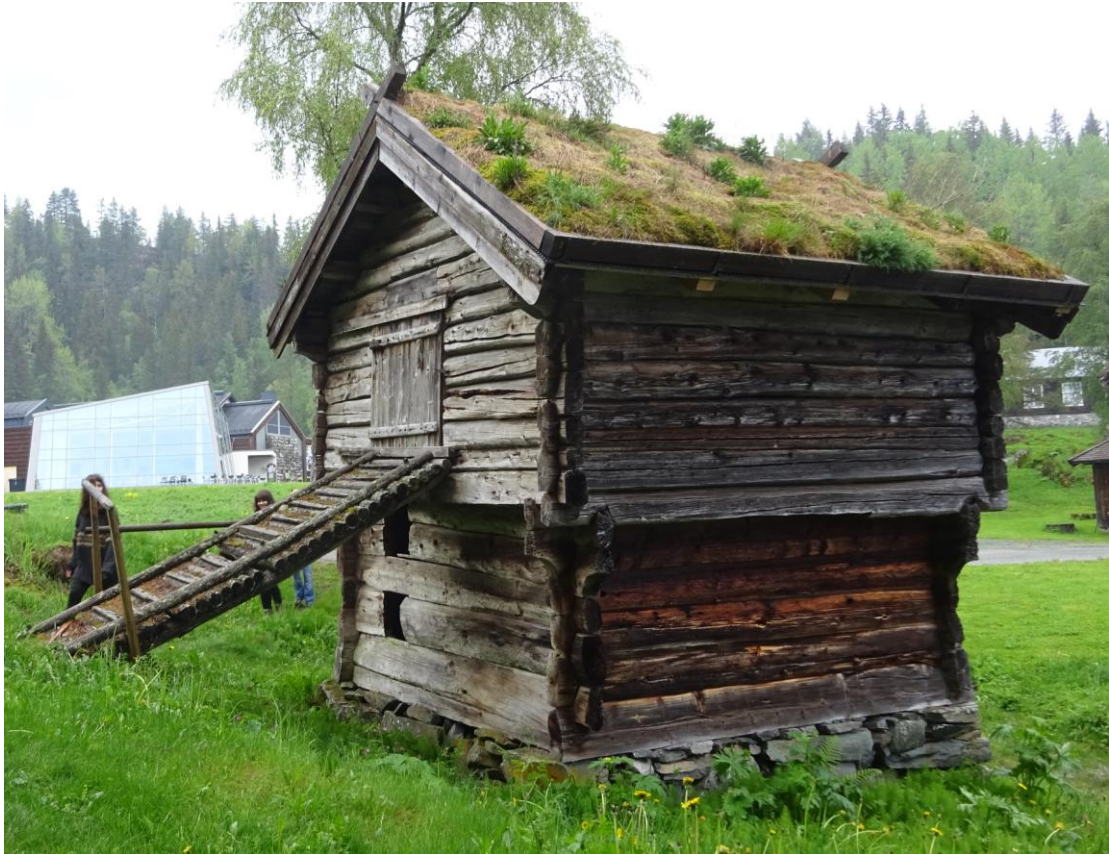
Obrázek 2 - Bývalá zemědělská stavba využívající hranoly
