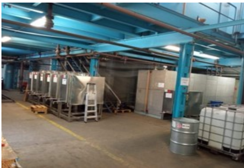
Obrázek 7 - Prostory skladování nebezpečných látek (zdroj: vlastní)
