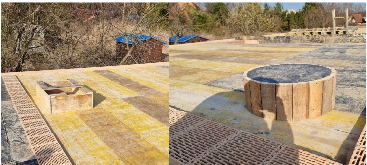
Obr. 36 – Bednění stavebních prostupů (vlastní zpracování)
