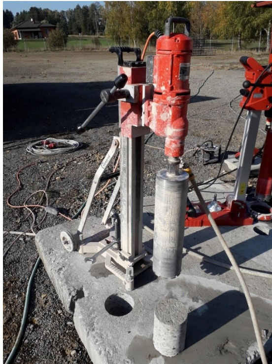
Obr. 37 – Jádrové vrtání
