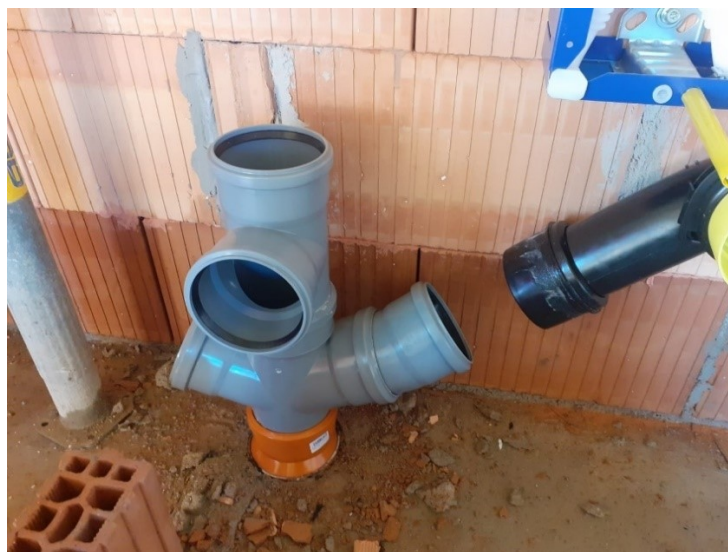
Obr. 38 – Prostup kanalizace (vlastní zpracování)
