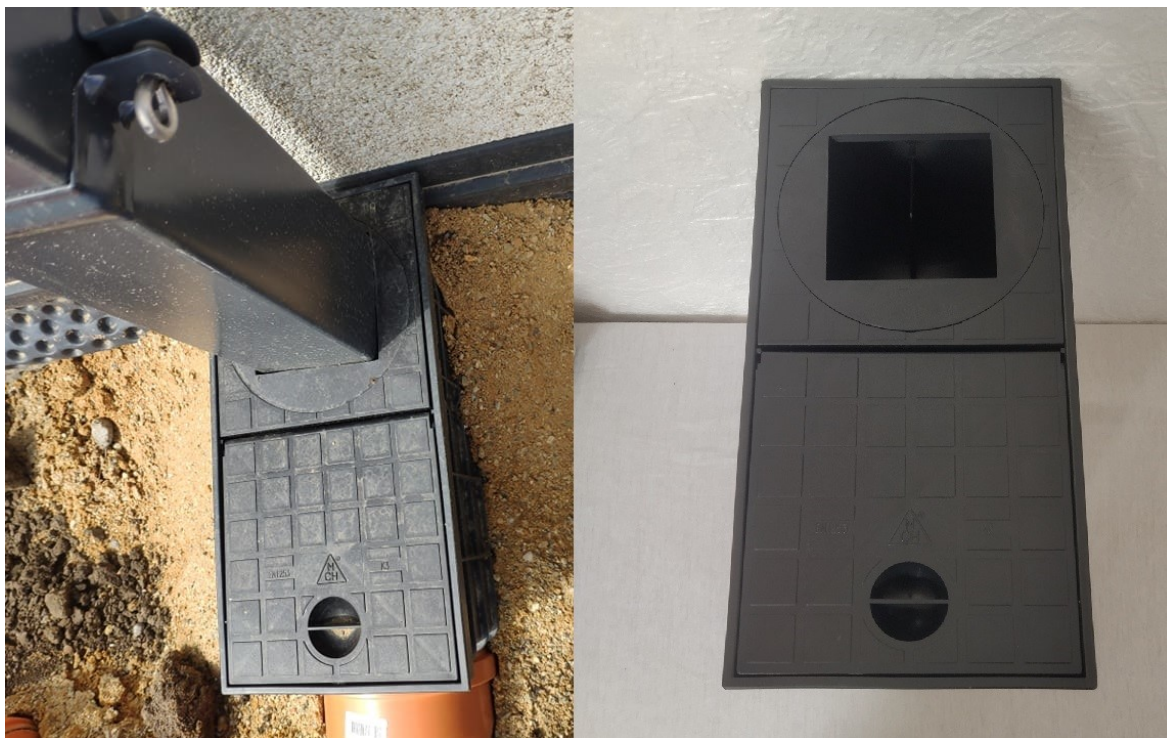
Obr. 42 – Aplikace redukce pro hranaté svody (vlastní zpracování)
