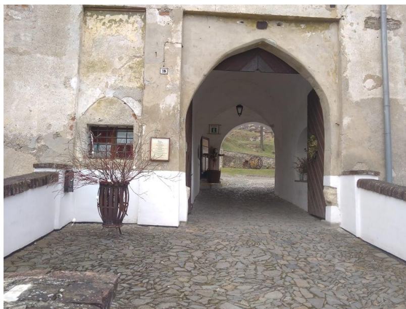
Obr. 4 – Problémový průjezd na nádvoří (vlastní)
