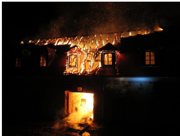
Obr. 6 – Požár části západního křídla (Ondruch, 2016)
