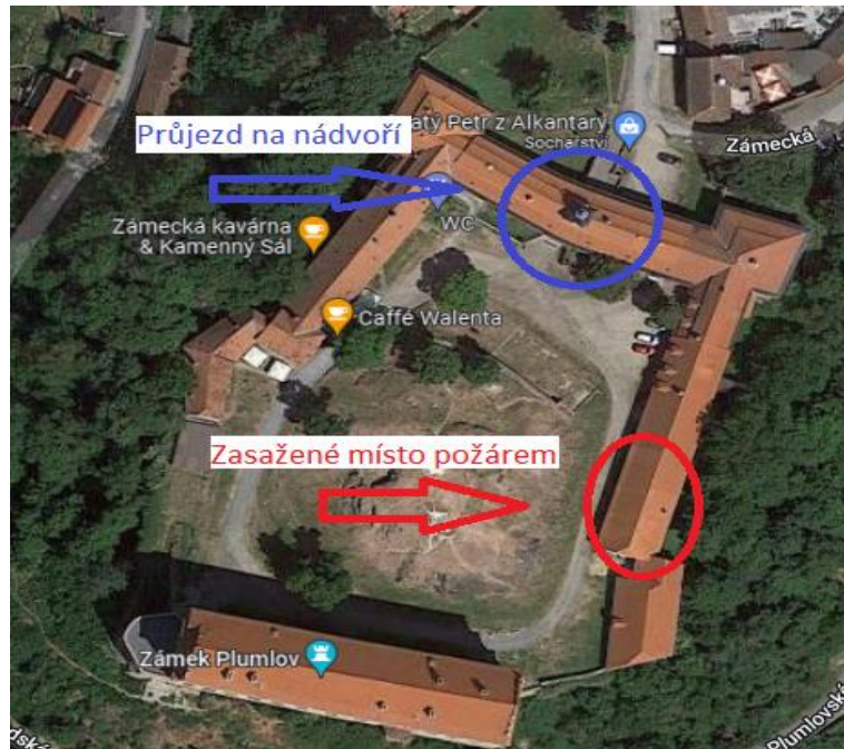
Obr. 5 – Nádvoří s vyznačením požáru (Google maps, 2022)
