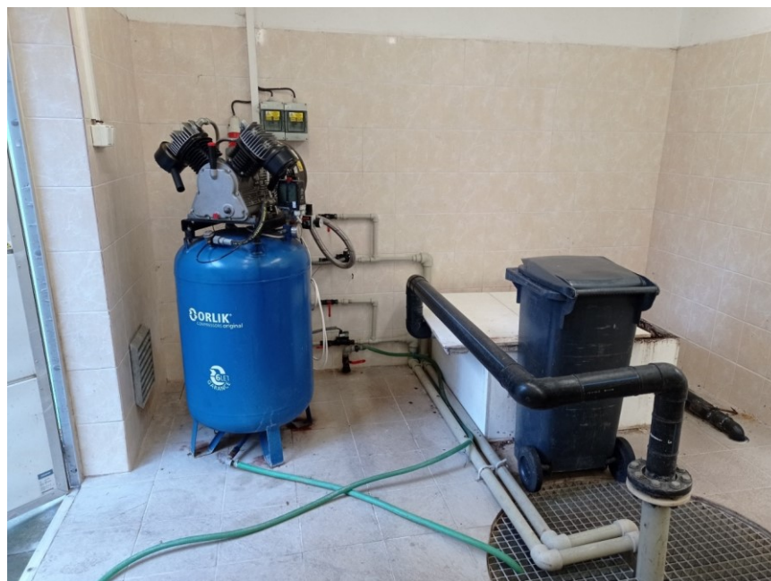
Obrázek 9 Lapák písku s kompresorem Orlík (vlastní)
