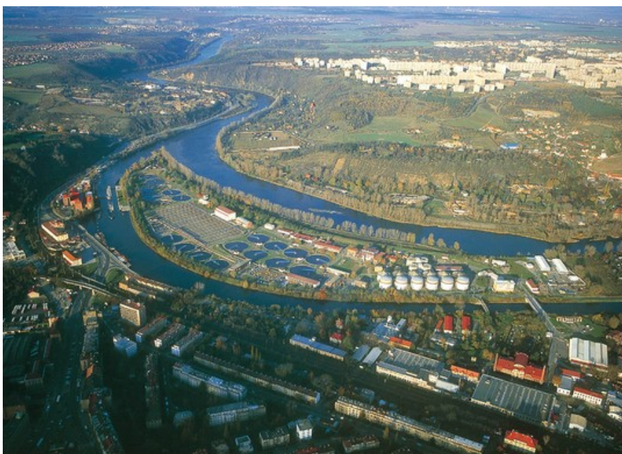
Obrázek 3 Čistírna odpadních vod Praha (Pražské vodovody a kanalizace, ©2022)
