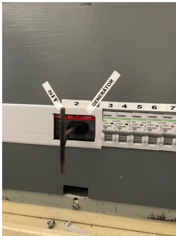
Obrázek 10 Přepínač zdroje elektrické energie (zdroj vlastní, 2022)
