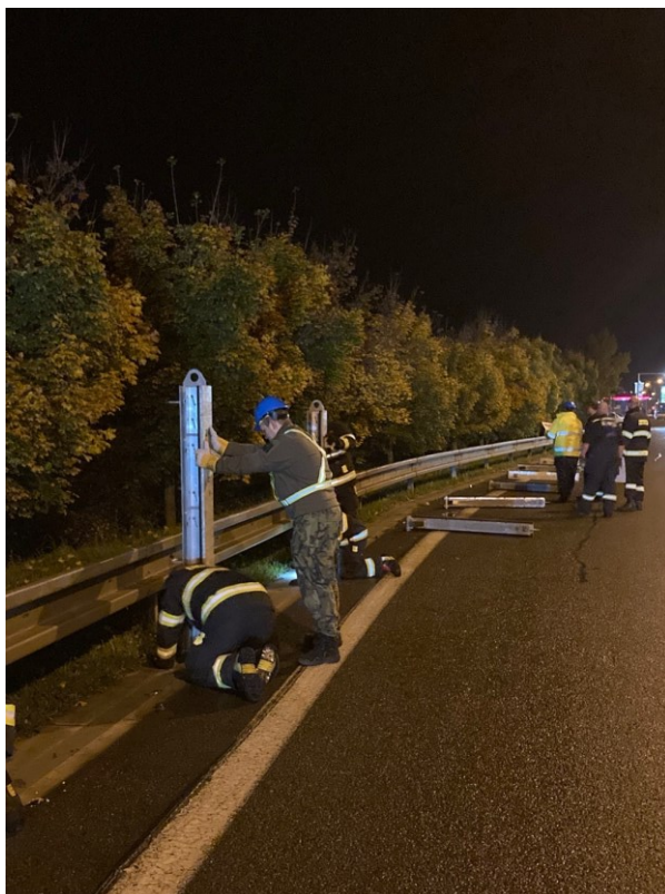
Obrázek 7 Výstavba PPO 1 (zdroj vlastní, 2022)
