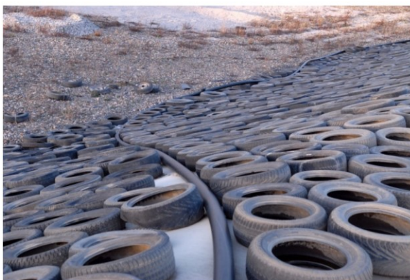
Obrázek 6 Ochranná vrstva pneumatiky při výstavbě skládky odpadu
