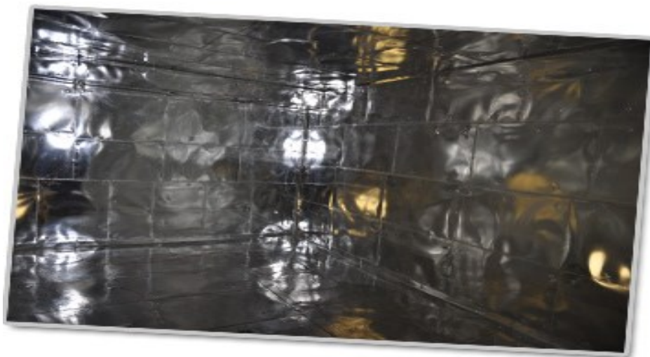
Obrázek 4: Faradayova místnost (Zdroj: Mudroch Labs s.r.o., 2011)
