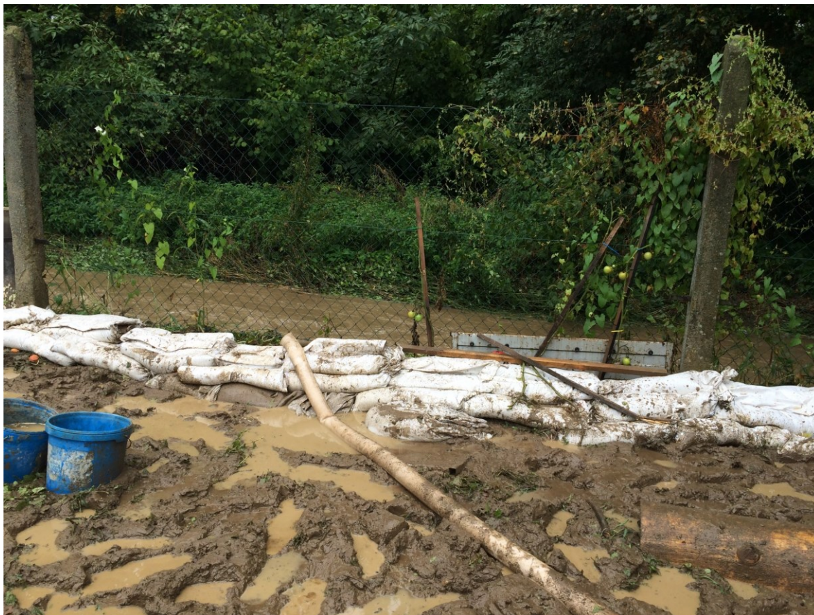
Obrázek 27 – Protipovodňová hráz (JSDH Drnovice, 2014)
