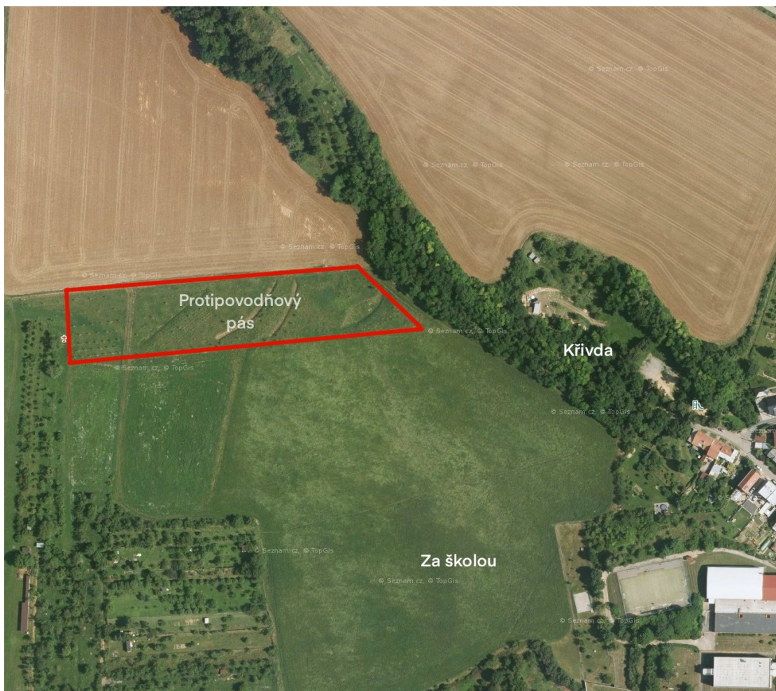
Obrázek 46 – Vybudovaný protipovodňový pás (zdroj vlastní, 2023)
