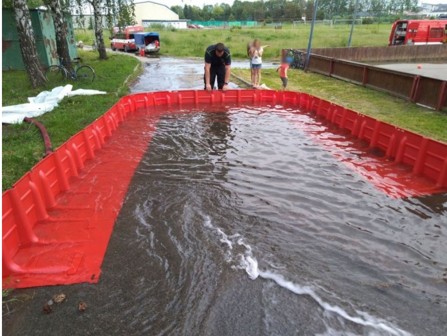
Obrázek 11 – Mobilní protipovodňová ochrana NOAQ Boxwall (Výzbrojna.cz, 2023)
