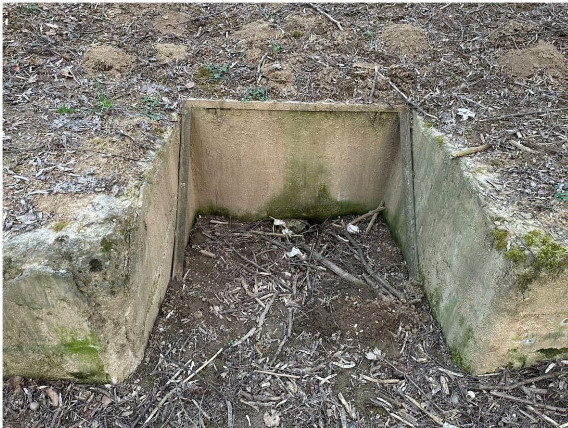
Obrázek 47 – Vpust' pro odtok vody - Křivda (zdroj vlastní, 2023)
