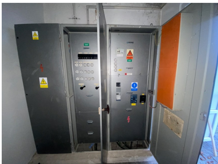
Obrázek 2 - Hlavní jistič (vlastní,2023)
