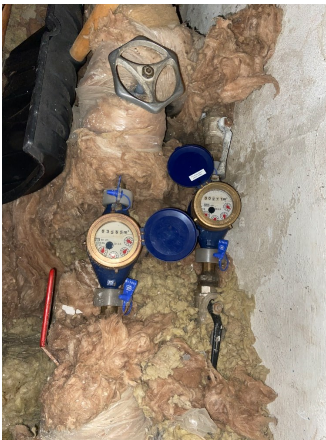
Obrázek 1 - Hlavní uzávěr vody (vlastní,2023)
