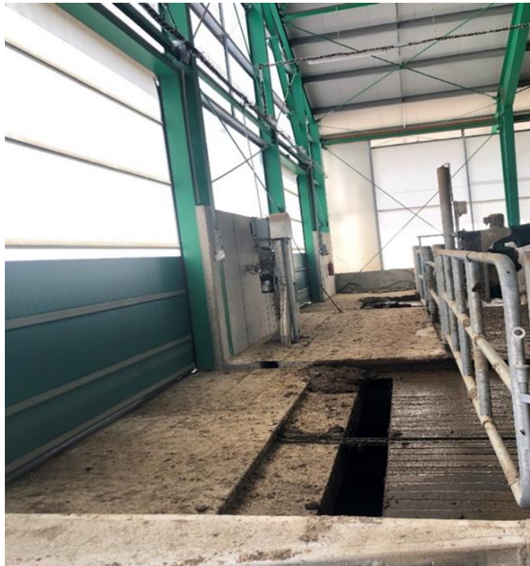
Obrázek 8 Špatné řešení ÚC ve stáji I. (zdroj vlastní, 2023)
