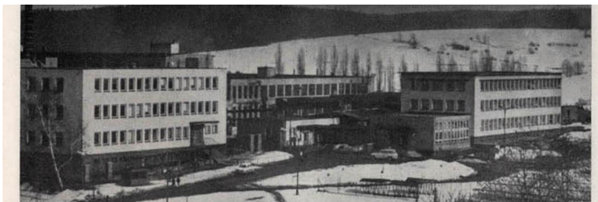
Obr. 3 Areál Elektrotechnické Společnosti Akciové (zdroj: ETA Blog, © 2022)
