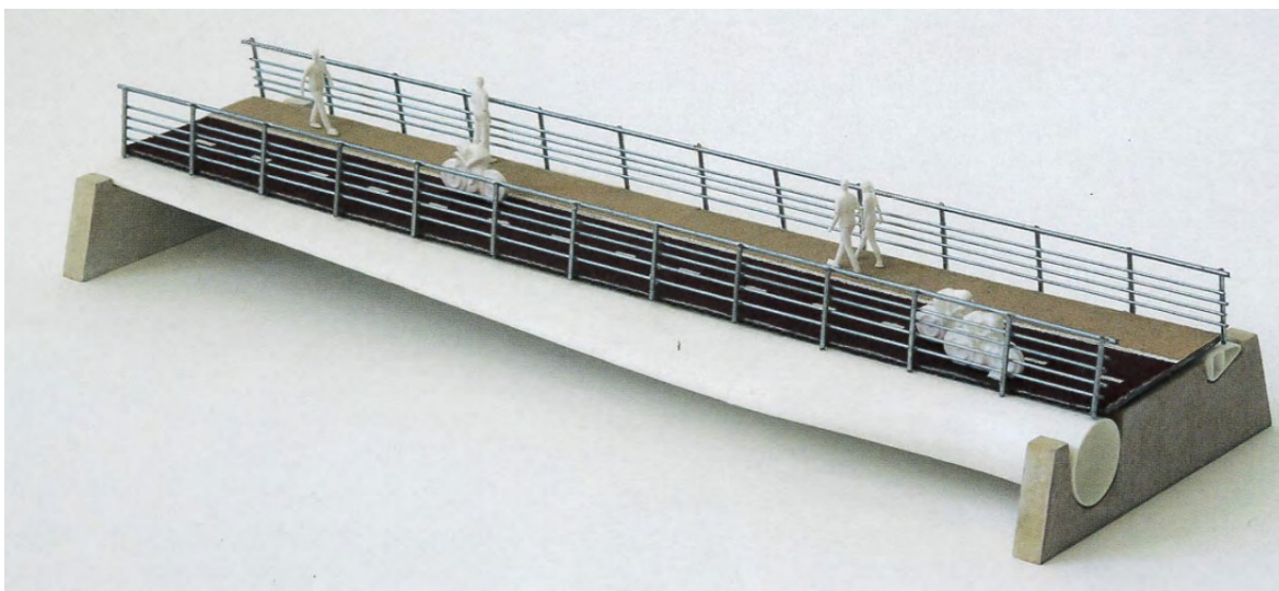
Obr. 30 Nosníky lávky z listů větrných elektráren [33]
