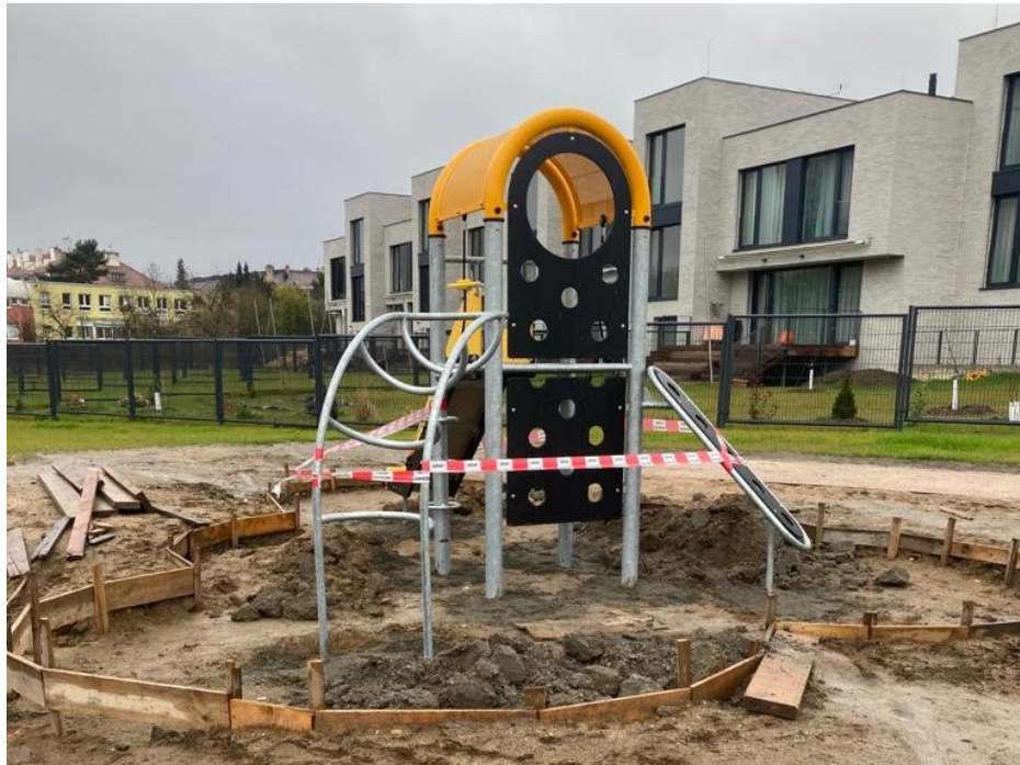
Obrázek 15 Realizace prvku Kryptos III – pohled na nosné stojky s přidělaným obloukem (interní zdroje firmy hřiště.cz)
