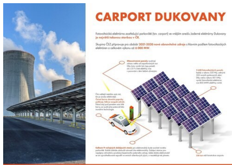
Obrázek 19 Systém Carport Dukovany (zdroj: cez.cz)
