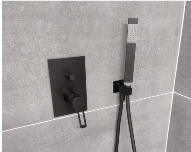
Obrázek 7 Páková baterie Paffoni s podomítkovou instalací
