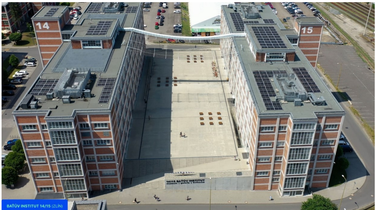
Obrázek 8 Instalace FVE (vlastní zpracování, interní materiály společnosti)
