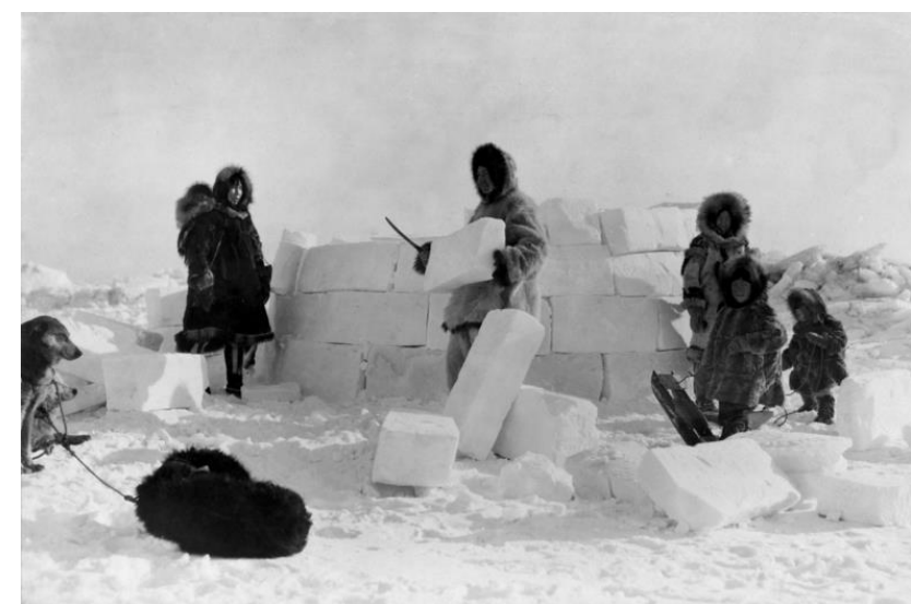
Obr. 5. Eskymáci stavějící iglú (zdroj: KLEINSCHMIDT, 1924)
