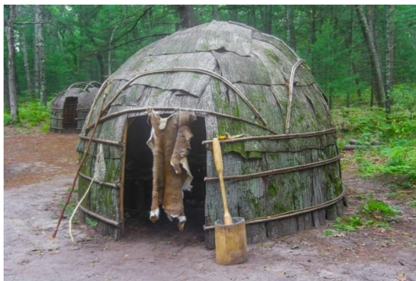
Obr. 4. Vigvam s kupolovou konstrukcí (zdroj: ROSSOGRAPH, 2015)
