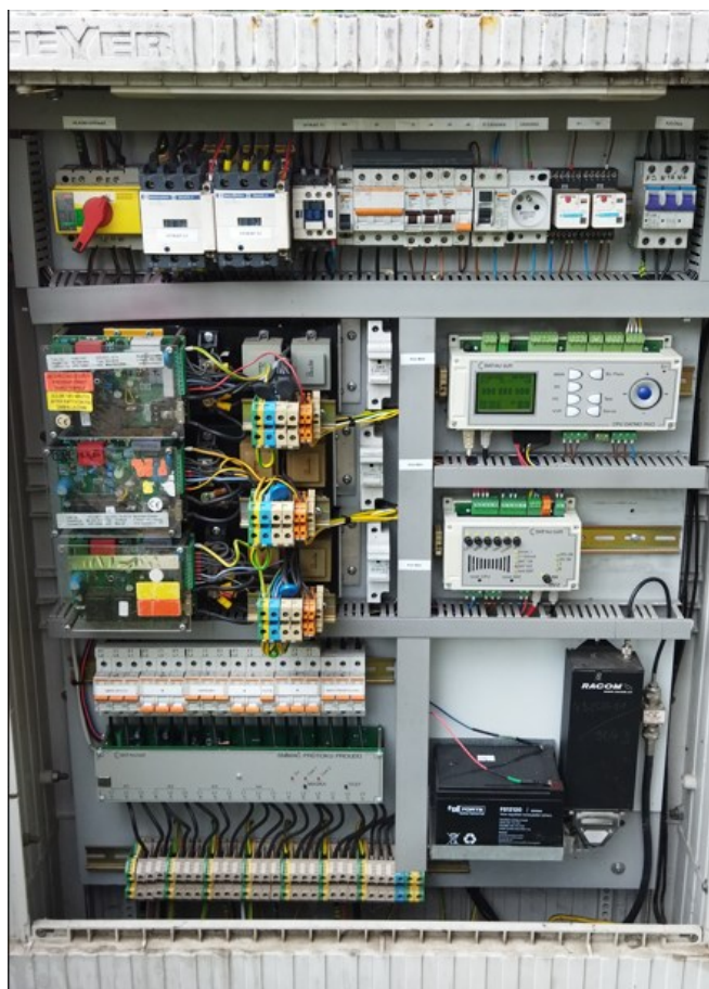
Obrázek 6 Rozvaděč VO s centrální regulací [vlastní]
