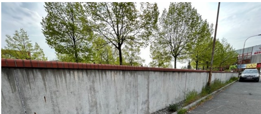
Obrázek 16 Betonová zeď oddělující parkoviště a náměstí [vlastní]
