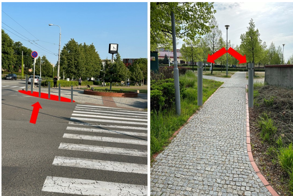
Obrázek 24 Zabezpečení ocelovými sloupky HOSPA [vlastní]
