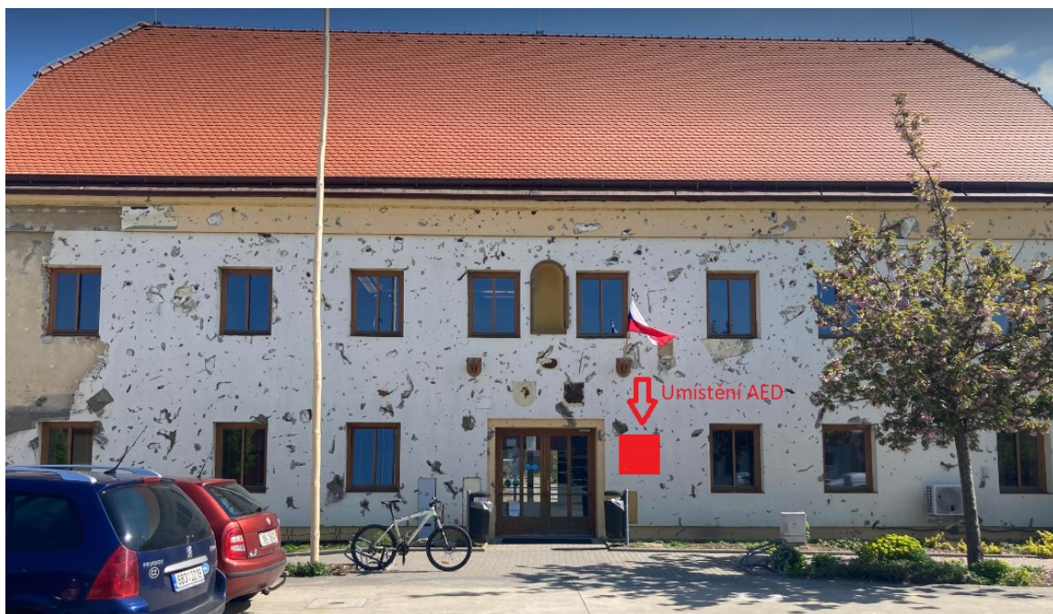
Obrázek 13 Umístění přístroje AED na obecním úřadě (vlastní)
