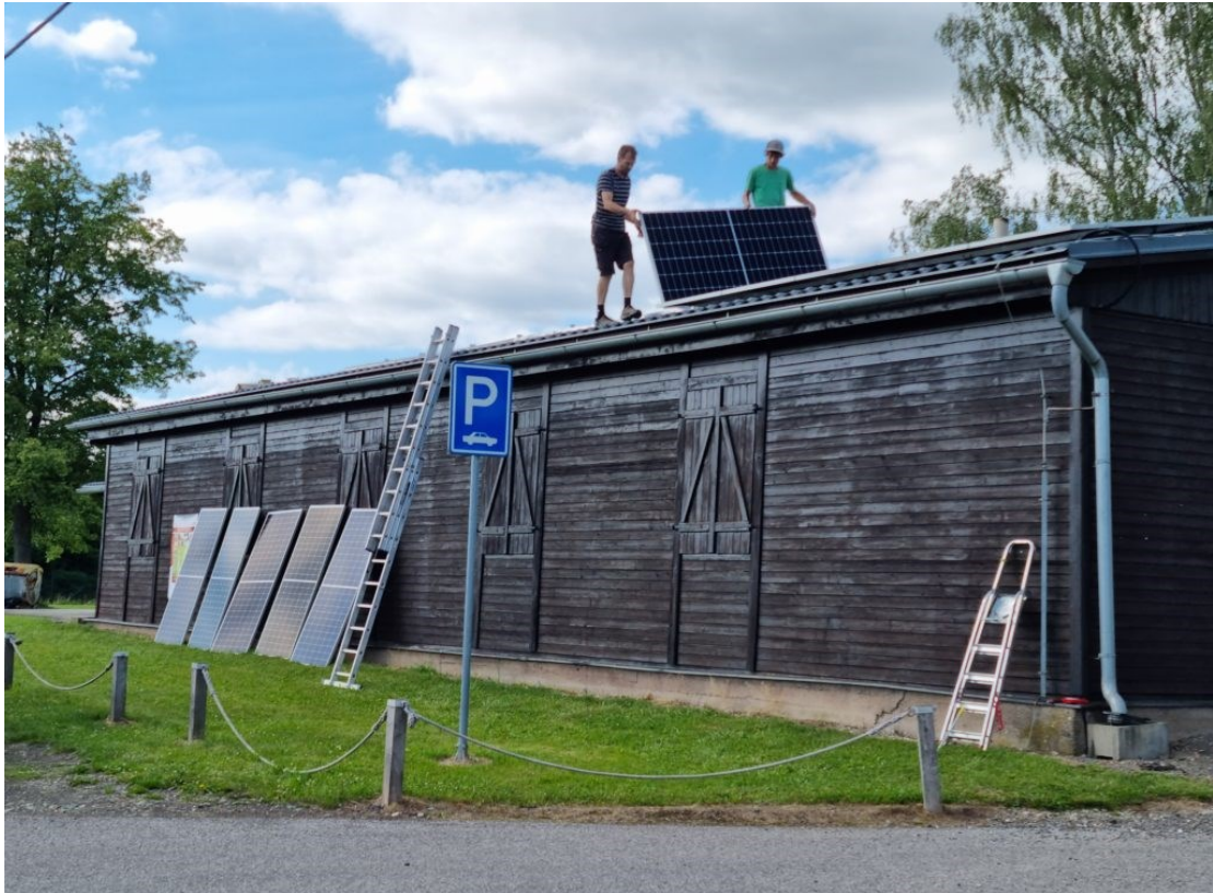
Obrázek 12 Instalace FVE na obecní sokolovně (Obec 2030, 2023)
