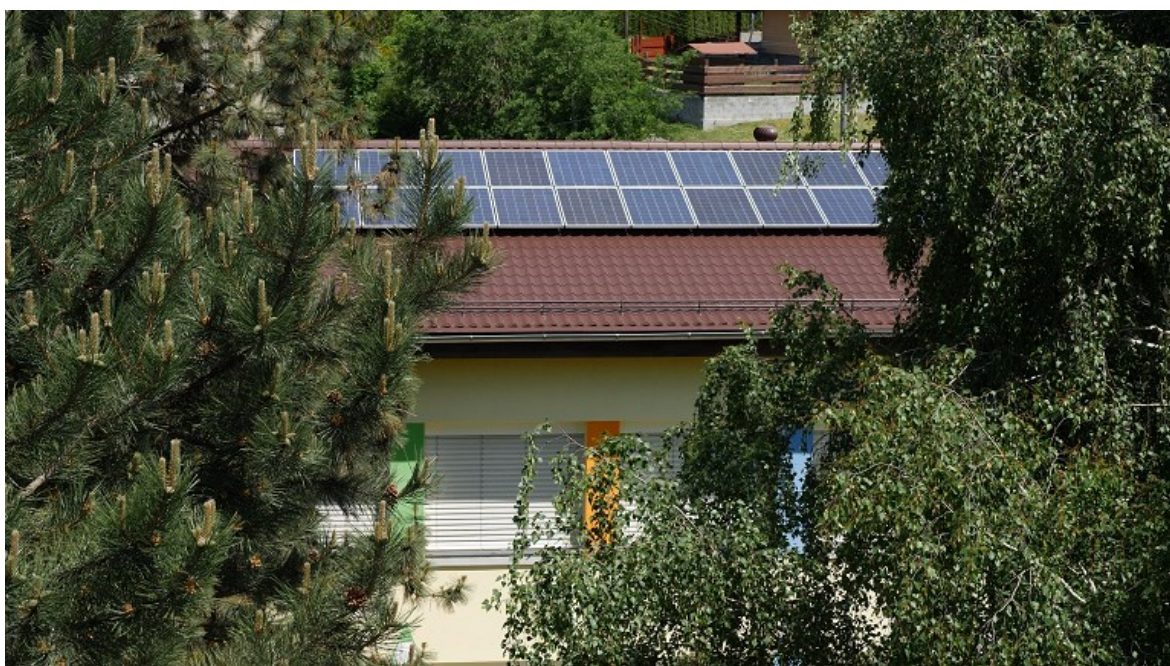
Obrázek 7 Fotovoltaická elektrárna Litultovice (Skupina ČEZ, 2022)
