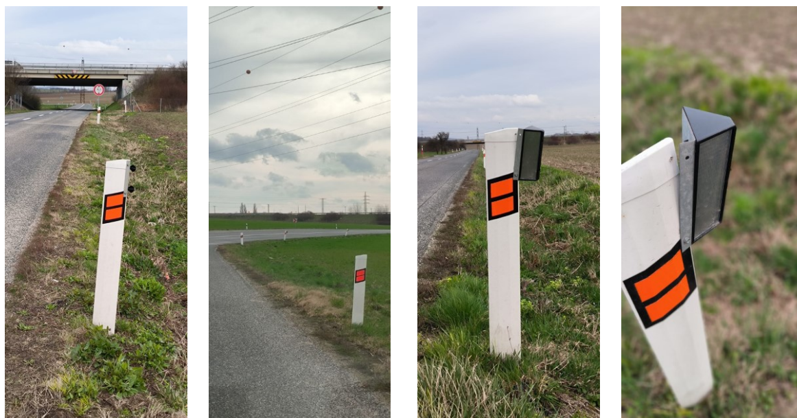
Obrázek 19 Chybějící nebo poškozené optické odrazníky proti zvěři na silnici č. 438 (Vlastní fotografie)
