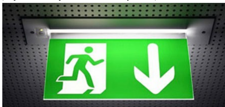
Obrázek 5: Nouzové únikové osvětlení (LEDsvítli.cz, 2017)
