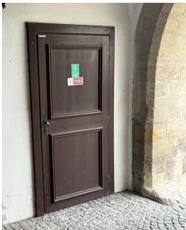
Hlavní uzávěr elektrické energie (Zdroj: vlastní zpracování, 2024)
