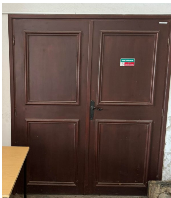
Hlavní uzávěr plynu (Zdroj: vlastní zpracování, 2024)
