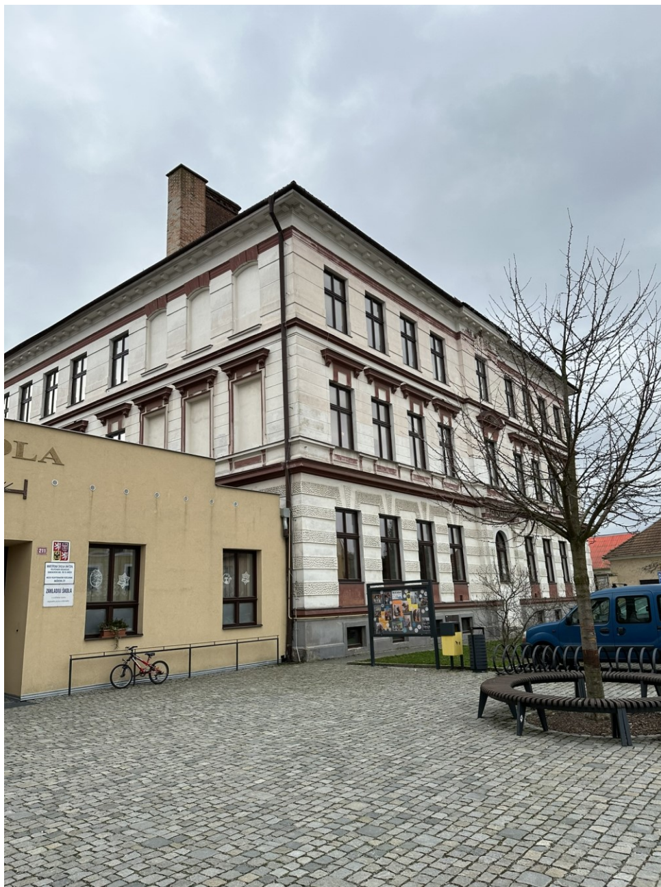
Obrázek 6 – Budova druhého stupně (vlastní)
