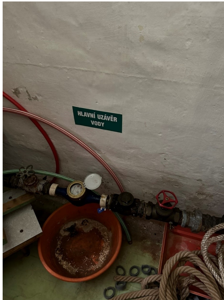
Obrázek 7 – Hlavní uzávěr vody (vlastní)
