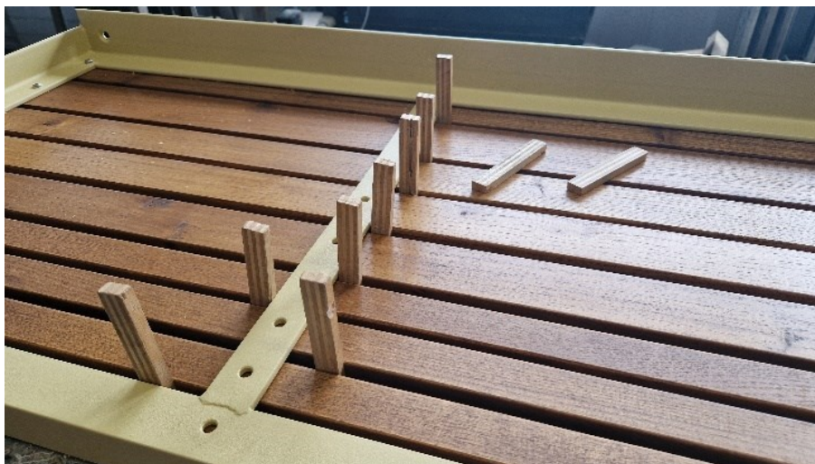
Obr. 55 Vytyčené mezery mezi prkny pomocí špalků
