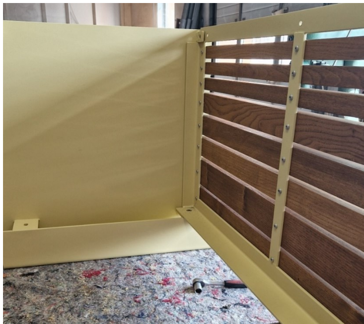
Obr. 57 Spojování konstrukce květináče
