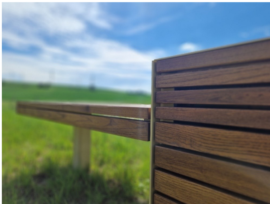
Obr. 63 Detail řazení prken květináče a lavičky
