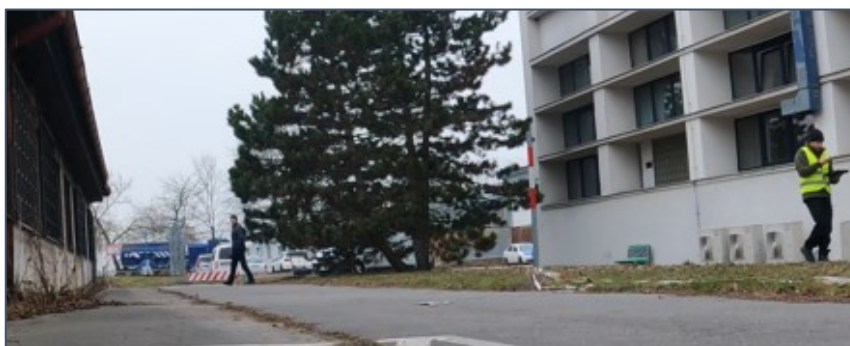
Obrázek 95 Průchod do detekční zóny 3/3 – pohled z venku [Foto autor]
