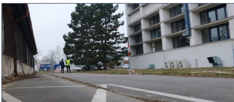
Obrázek 88 Průchod do detekční zóny 4/4 – pohled z venku [Foto autor]
