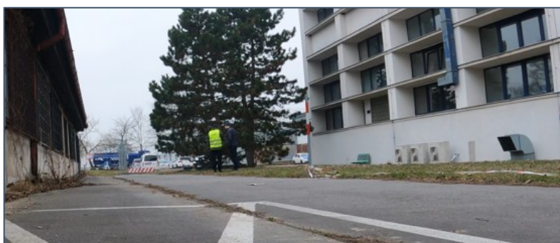
Obrázek 86 Průchod do detekční zóny 2/4 – pohled z venku [Foto autor]
