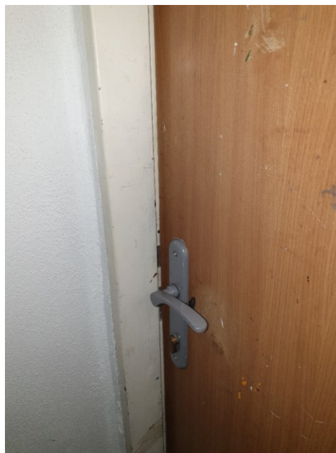
Obrázek 6 - požární dveře výrobní hala (zdroj vlastní)
