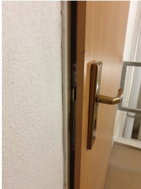
Obrázek 5 - požární dveře administrativní část (zdroj vlastní)
