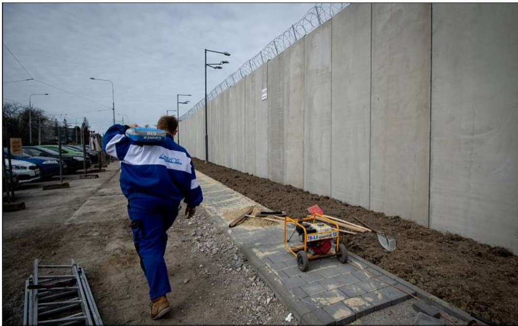
Obrázek 12 - Stavba nové zdi ve Věznici Heřmanice [15]
