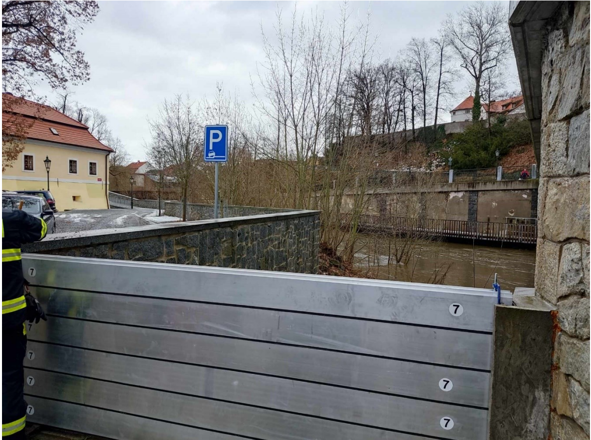
Obrázek 1 – Kombinace protipovodňové zdi a mobilního systému v obci Vlašim (vlastní fotografie)
