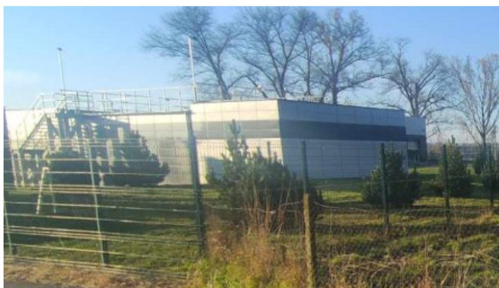
Fotografie č. 7: Čistička odpadních vod (Mareš, 2023)
