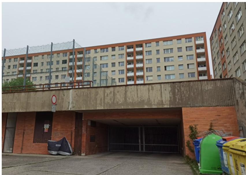
Garážové stání v ulici Na Honech I (Vlastní)
