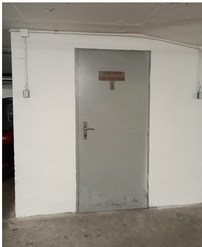
Vchod do strojovny (Vlastní)
