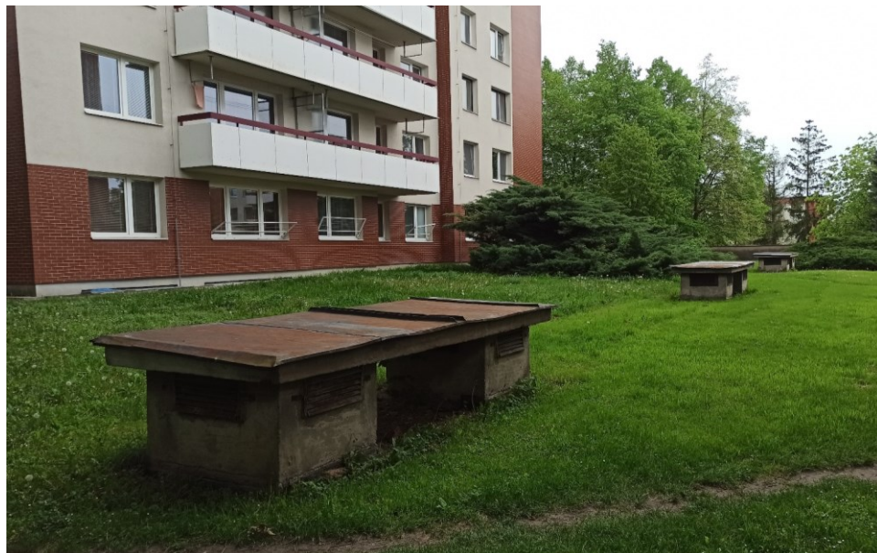
Vzdušné průduchy vyvedené na povrchu (Vlastní)
