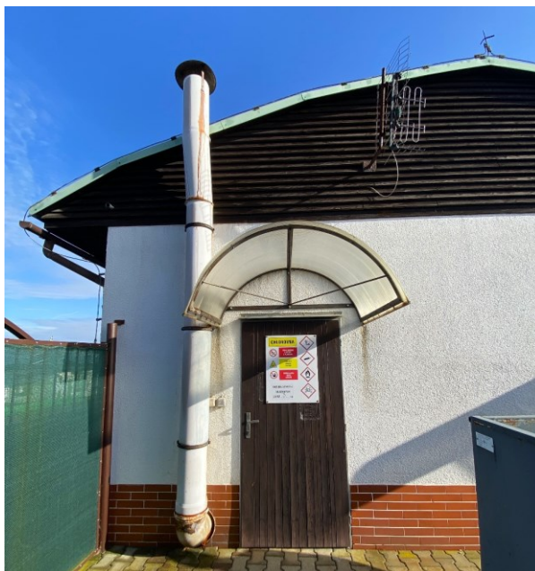
Obrázek 10: Vstup do chlorovny (vlastní)
